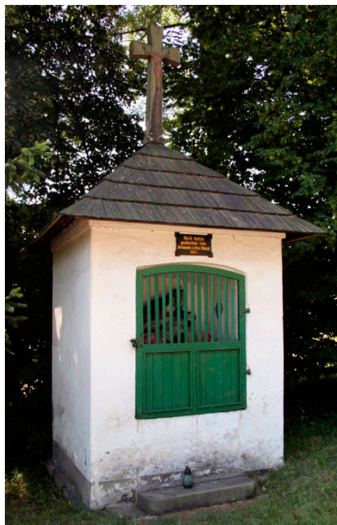
Kaple zvaná Švédská z konce 17. století v Mostech u Českého Těšína
